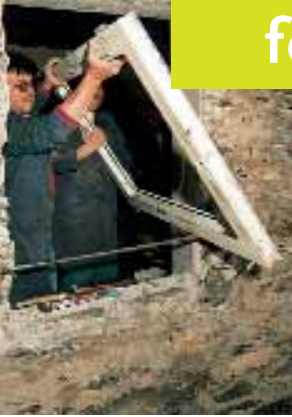
Ausbau von Altfenstern
